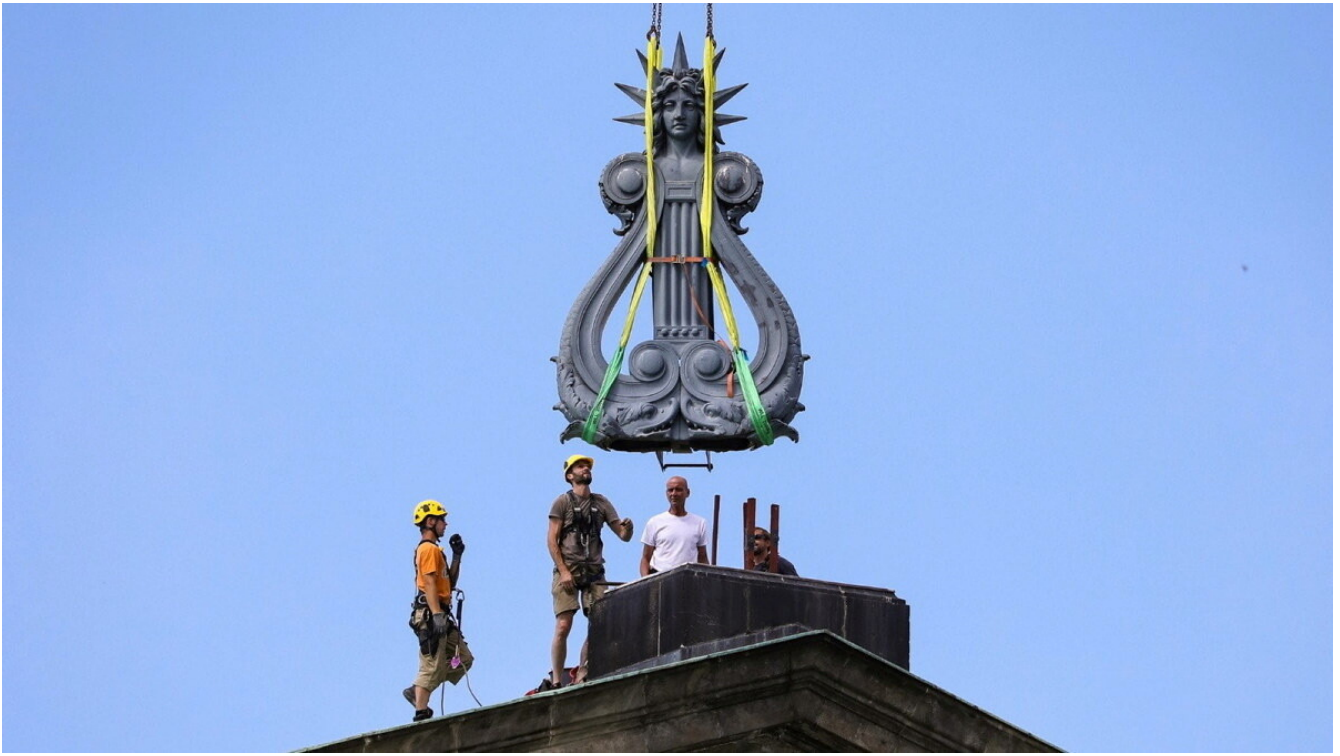
Im Juli vergangenen Jahres wurde diese Lyra und fünf weitere Großplastiken mit dem Kran vom Dach der Semperoper gehoben. © Tino Plunert
