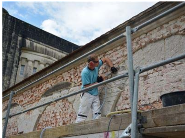
Hoch über Restaurator Ralf Vogelreuter von der Firma Fuchs und Girke kreisen die Turmfalken, die im Krematorium brüten. Unter ihnen entsteht die Ansicht des Ostflügels neu.
