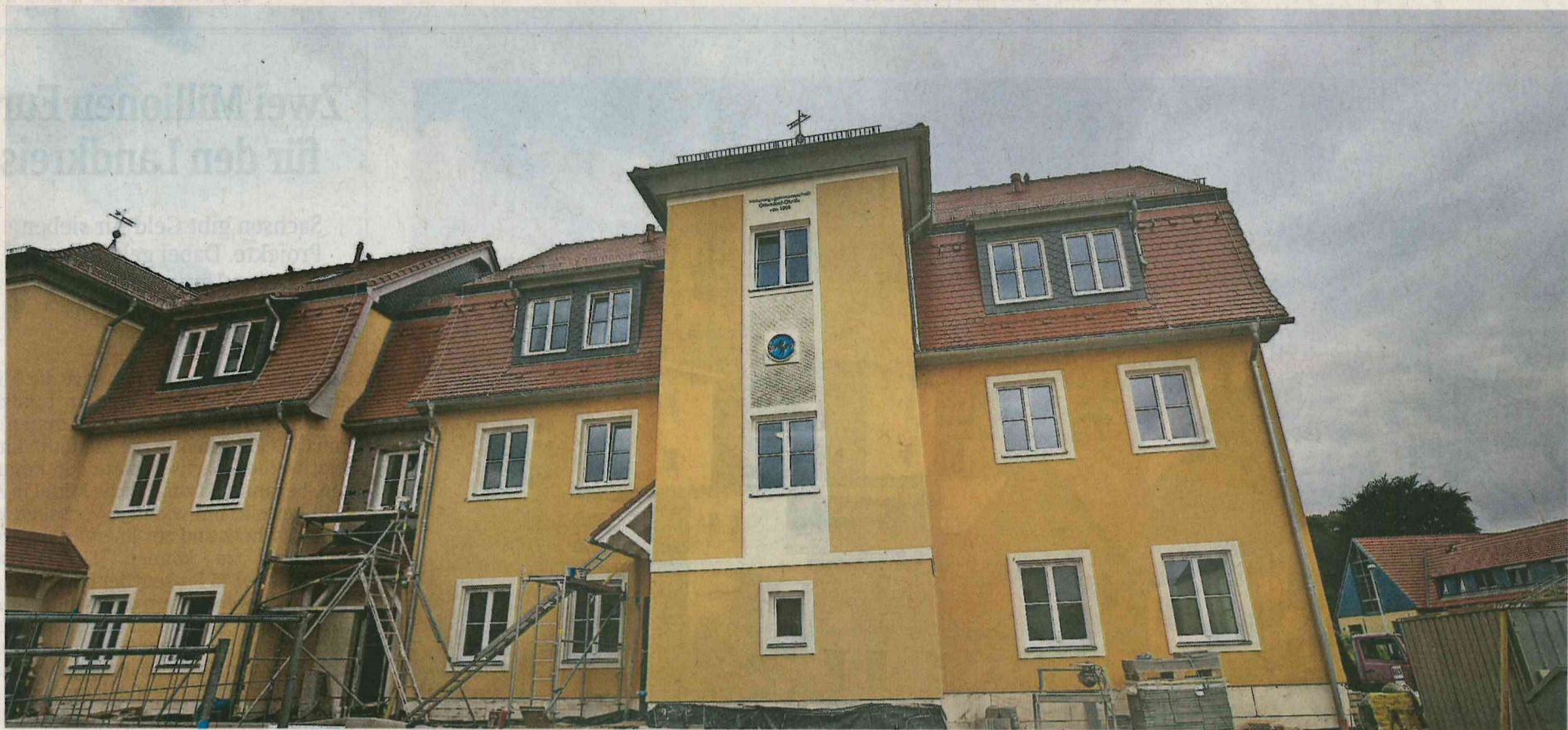
Das Mehrfamilienhaus am Rossplatz kann pünktlich zur Geburtstagsfeier der Ottendorfer Wohnungsgenossenschaft am 7. Juli eingeweiht werden. Die insgesamt elf Wohnungen sind allesamt vermietet.
