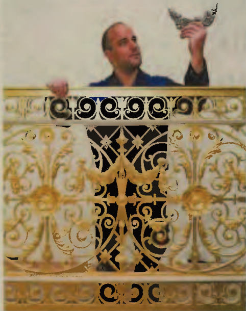
Hinter Steffen Aurin und seinem Team liegen 2 300 Stunden der Sisyphus-Arbeit. Das Ballsaal-Geländer im Residenzschloss wurde mit 2 104 Zinkgussteilen rekonstruiert.
