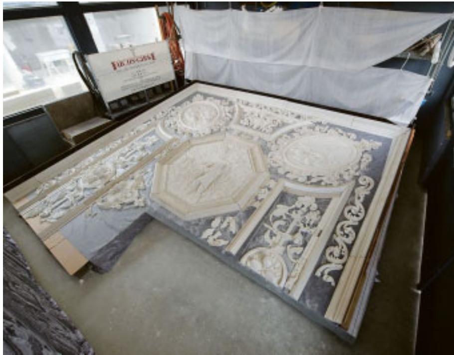
Wie ein Mosaik: Zur Hälfte ist die Stuckdecke, von der historische Fotos (Mitte) überliefert sind, schon fertig. Der Architekt Jochem Jourdan (ganz rechts) begutachtet die Motive.
